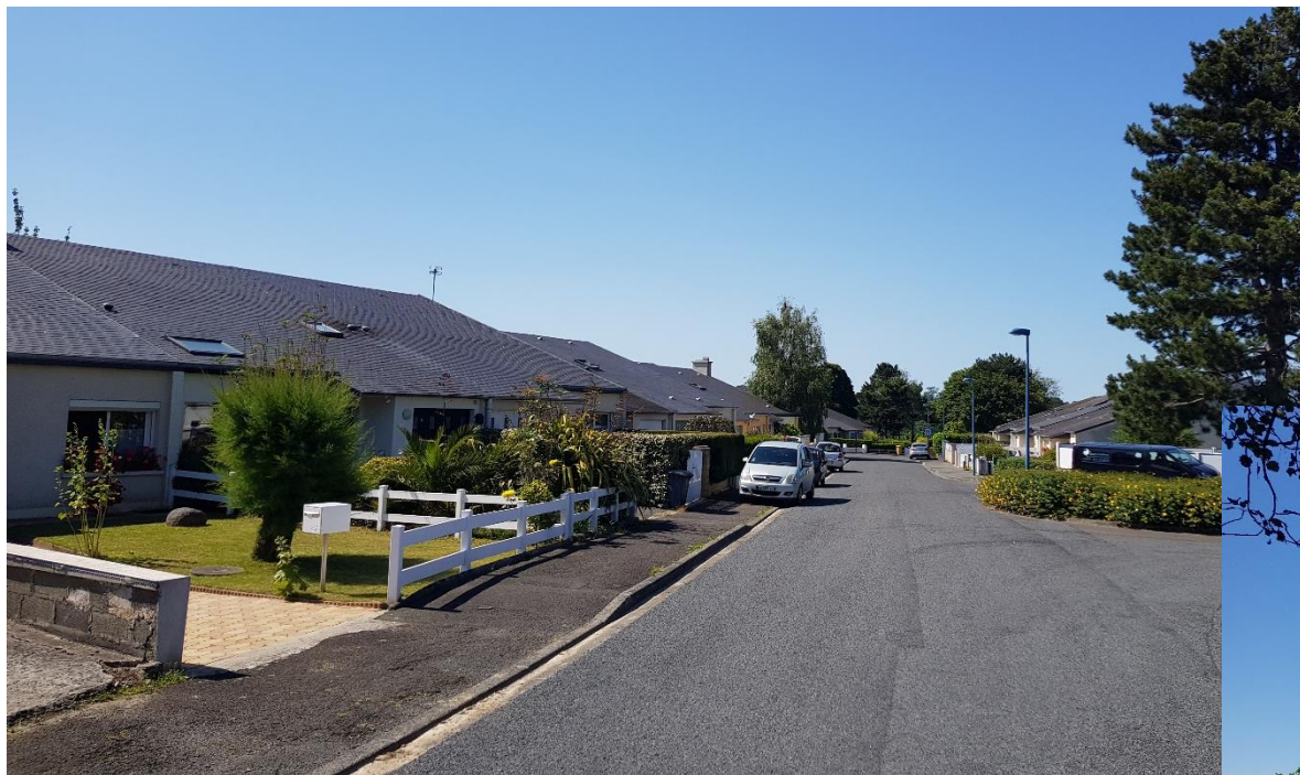
SAINT-BRIEUC Autour de la rue de Cherbourg Année : 1970-1980 89 logements 3,4 ha Densité : 27 logts/ha
