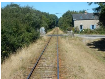
Passage à niveau automatique protégé
