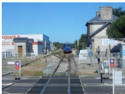
Gare de Plouharnel avec bâtiment et voie de croisement, aiguillage manuel Passage à niveau automatique Téléphone de ligne au passage à niveau Panneau indicateur kilométrique de la ligne (462 km de Paris via Nantes, ex réseau PO)
