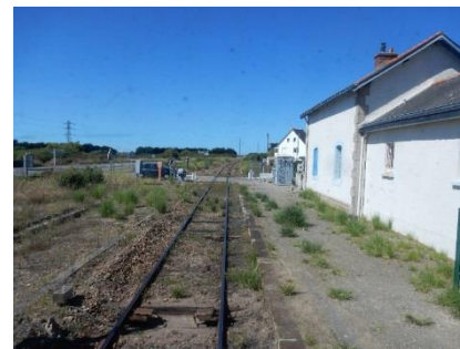
Gare de Kerhostin, quai sur un seul côté avec un bâtiment Les pédales de déclenchement pour la fermeture ou l'ouverture du passage à niveau automatique
