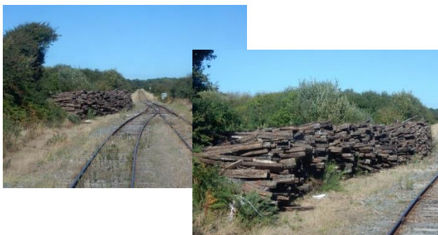
Sortie de la gare de Plouharnel Tas de traverses usagées
