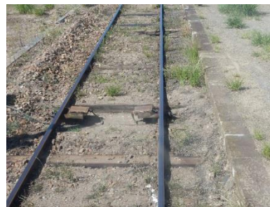
Pédales de déclenchement de l'ouverture ou de la fermeture du passage à niveau automatique
