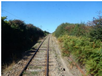
Des traverses en bois remplacées ici ou là
