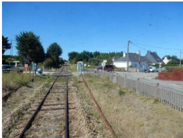
Passage à niveau automatique pour une traversée routière
