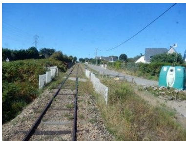
Une traversée de voie par « passe pieds » non protégé pour piéton voire vélo mais à pied
