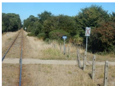
Passage au km 461 non protégé pour les besoins agricoles
