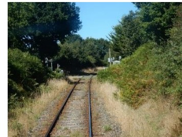
Passage à niveau automatique protégé en courbe
