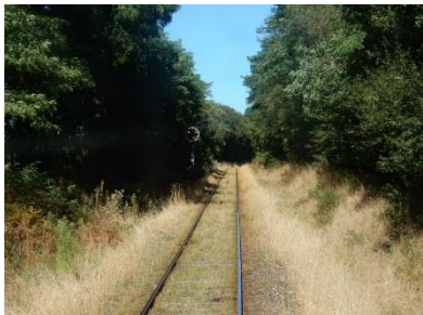
Signalisation d'entrée de la gare d'Auray annonçant le franchissement d'un aiguillage à 30 km/h
