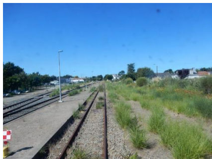
Gare de Quiberon Un quai, deux voies et une voie de garage Pas de signalisation hormis le jalon « Carré à damier blanc et rouge » qui interdit tout franchissement s'il est posé face au train à quai Foncier préservé
