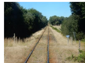
Traversée non protégée au PK 457 Ballast bien recouvert de végétation, sèche en saison d'été
