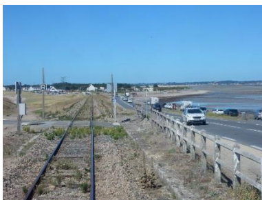
Passage à niveau routier non protégé Panneau de Reprise de la vitesse limitée de la ligne (60 km/h)
