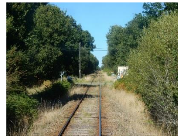
Passage à niveau automatique protégé
