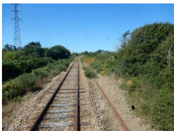
Un rail posé sur la piste en réserve pour des travaux éventuels
