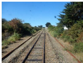
Des traverses en bois neuves ici ou là Rails sur la piste
